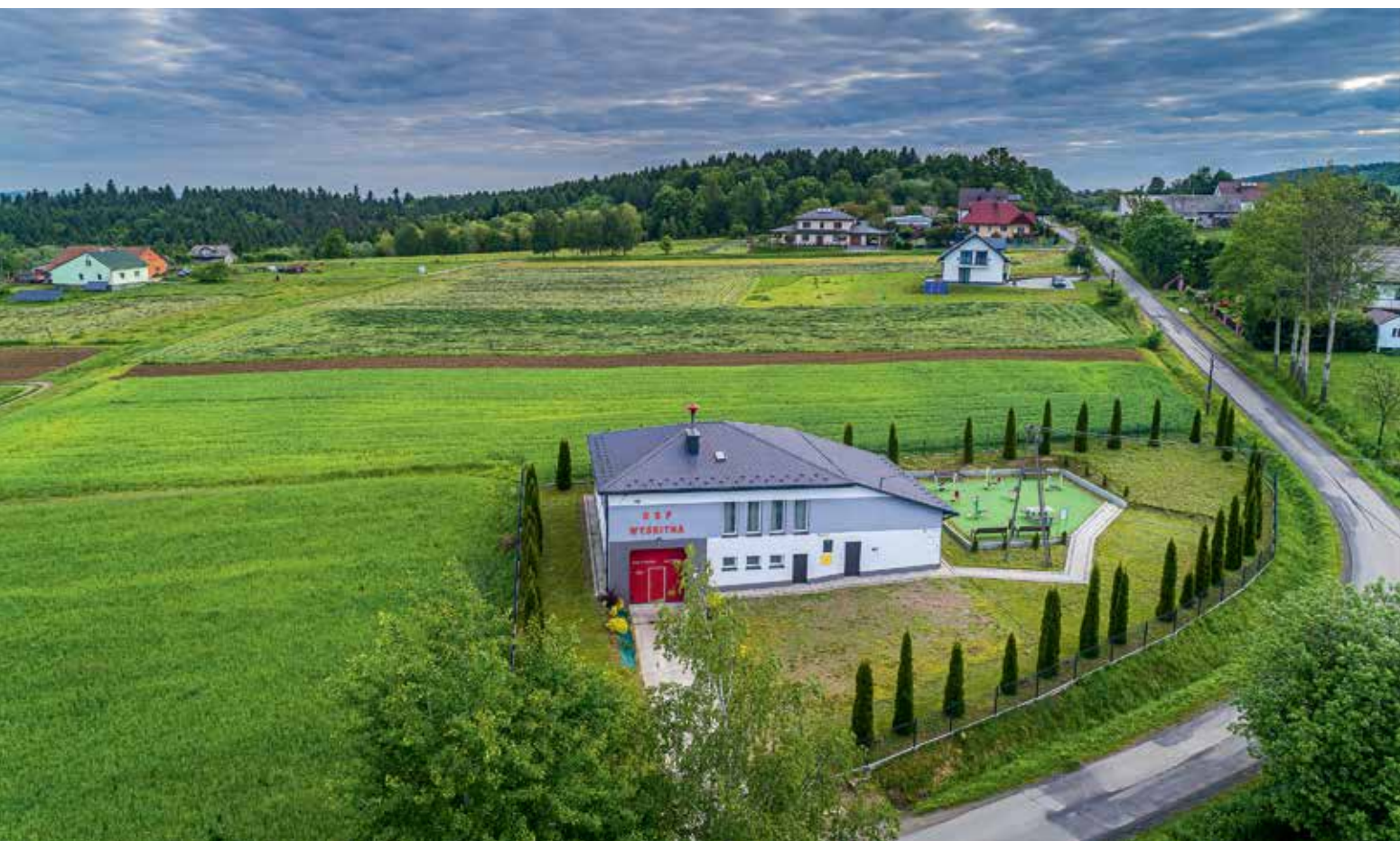
Remiza Ochotniczej Straży Pożarnej w Wyskitnej fot. Piotr Gaborek
